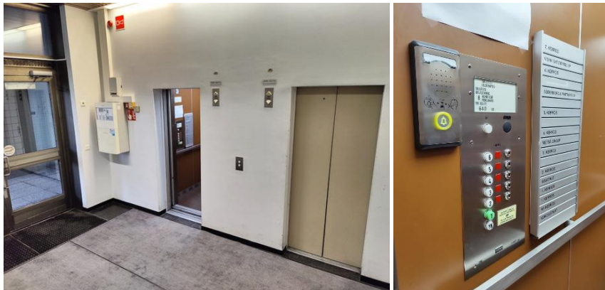
Kuva 35. Hissiaula katutasokerroksessa. Vaalea värimaailma toistuu myös rakennuksen sisätiloissa. Kuva 36. (oik.) Tarkempi kuva hissien varusteista. Hissi on Koneen valmistama ja siinä on vuosiluku 1981.
