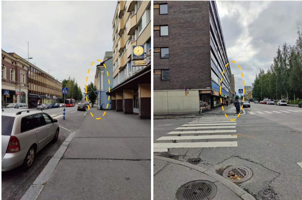
Kuva 41. (vas). Näkymä Savilahdenkadulta etelästä kohti konttorirakennusta. Uloke näkyy vaaleansinisen rakennuksen jälkeen. Kuva 42. (oik). Rakennus Savilahdenkadulla pohjoisesta katsottuna. Kohde esitetty keltaisella katkoviivalla.
