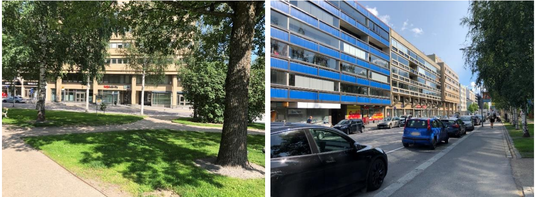
Kuva 22. (vas.) Inventoinnin kohteena oleva rakennus Kirkkopuistosta katsottaessa. Kuva 23. (oik) Porrassalmenkadun katujulkisivua. Liiketilat sijaitsevat katutasossa. Porrassalmenkatu 29 hahmottuu ulokkeena viereisistä rakennuksista ja on linjassa viereisen Porrassalmenkatu 31 ulokkeen kanssa. Porrassalmenkatu 31 sijaitsevalla Kiinteistö Oy Savilahdenpuistolla on omaleimaiset tukirakenteet. Porrassalmenkatu 33 kiinteistössä on voimakkaansiniset parvekekaiteet.
